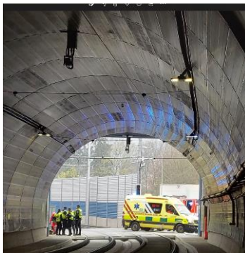
Obr. č. 6 Mimořádné události v tunelu patří vždy k těm náročnějším zásahům
